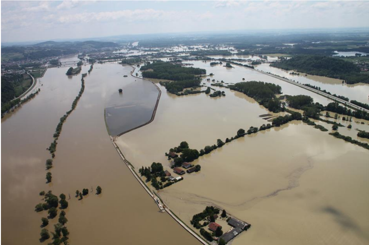
Abbildung 3: Überschwemmung im Stadtteil Fischerdorf (Bild: WWA Deggendorf)
