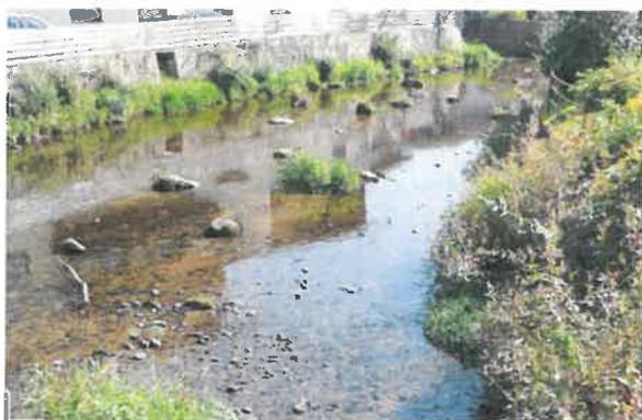
Abb. 3: eingebrachte Störsteine im unteren Abschnitt des Kleinen Regens (bei ca. Fkm 0,00 – 0,10)
