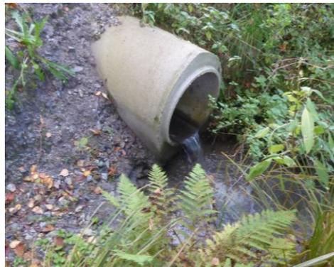
Abbildung 3: Seitenbach (links) mit verrohrter nicht durchgängiger Mündung in die Erlau (rechts) (Fluss-km 22,200)
