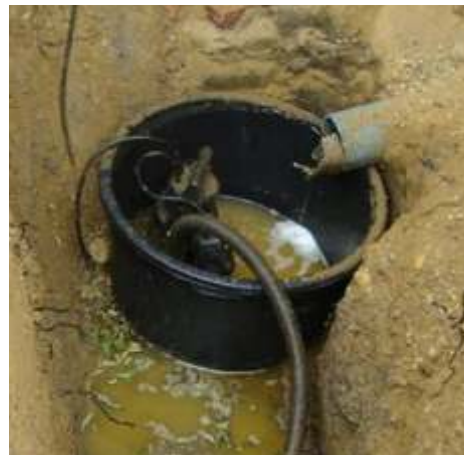
Abb. 6: Freilegen der Entwässerung, abpumpen und fachgerechtes entsorgen des Sickersaftes
