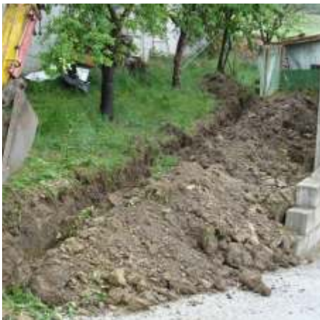
Abb 5: Freilegung der Entwässerung
