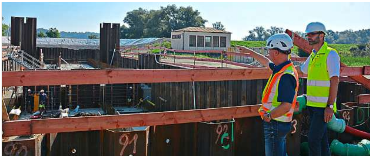
Bei Sophienhof entsteht aktuell das neue Schöpfwerk Entau. Oberbauleiter Christian Eckl (links) und Siegfried Ratzinger erläutern die Maßnahme. – Fotos: Arbinger
