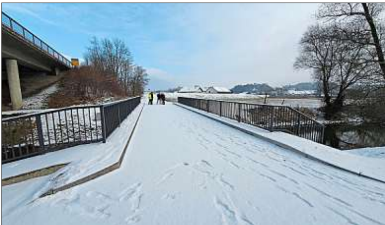
Die neue Brücke am Tag der letzten Baubesprechung – im Hintergrund die Ortschaft Winzer. – Foto: WWA
